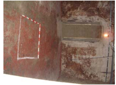
0073 Zona de comprovació- pavimen...
