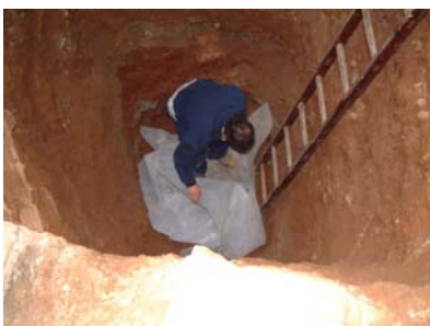
0115 Cala 4 col.locació del geotèxtil...
