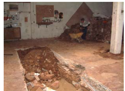
0102 Rasa 1 treballs de rebliment .J...
