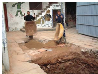
0116 Cala 4 abocament del sauló .J...
