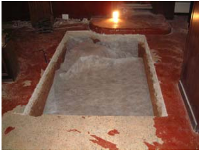
0106 Cala 2 amb geotèxtil .JPG
