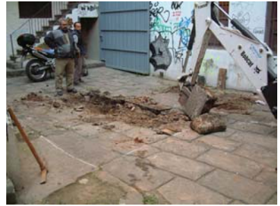
0078 UE 401 desmuntatge .JPG
