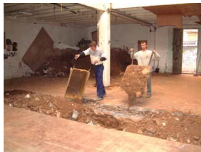
0101 Rasa 1 treballs de rebliment .J...
