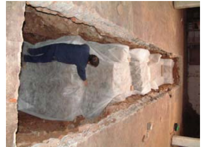
0097 Rasa 1 col.locació del geotèxti...
