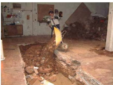
0103 Rasa 1 treballs de rebliment .J...
