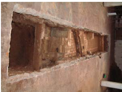
0042 Rasa 1 general final (W).JPG
